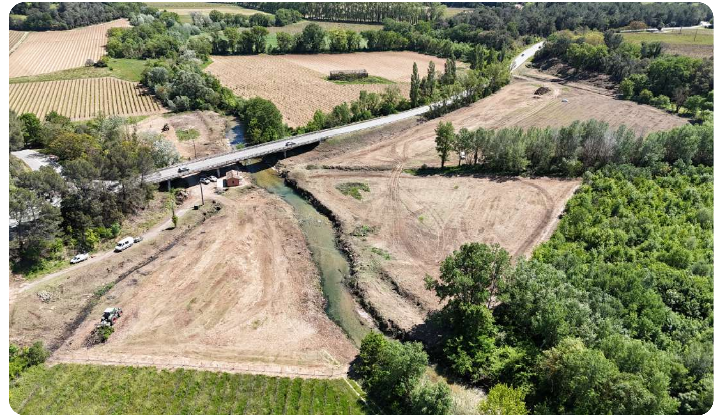
EMPRISE DU BARRAGE DE RALENTISSEMENT HYDRAULIQUE TRANS-EN-PROVENCE
