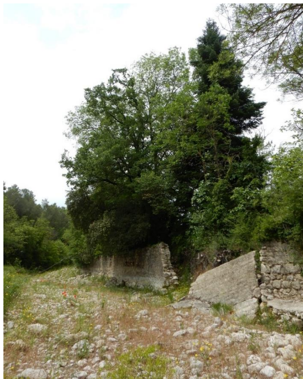
Maçonneries à retirer dans le cadre de l'action 34.
