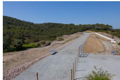
Barrage de l'Aspé inauguré le 19 juin 2025
