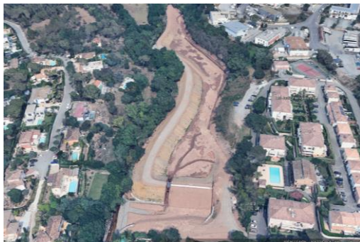
Bassin de Vaulongue réceptionné en novembre 2023
