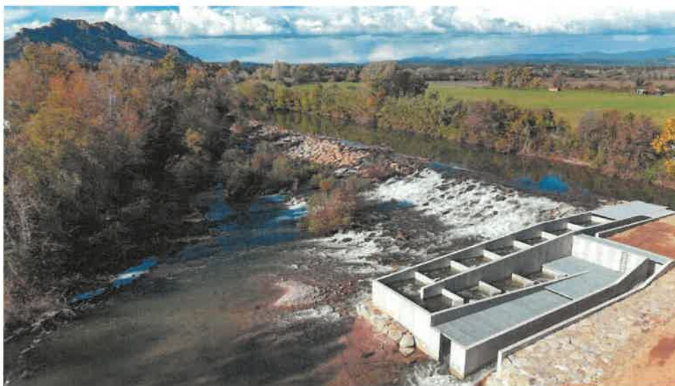
Seuil du Béal aménagé avec la passe à poissons
