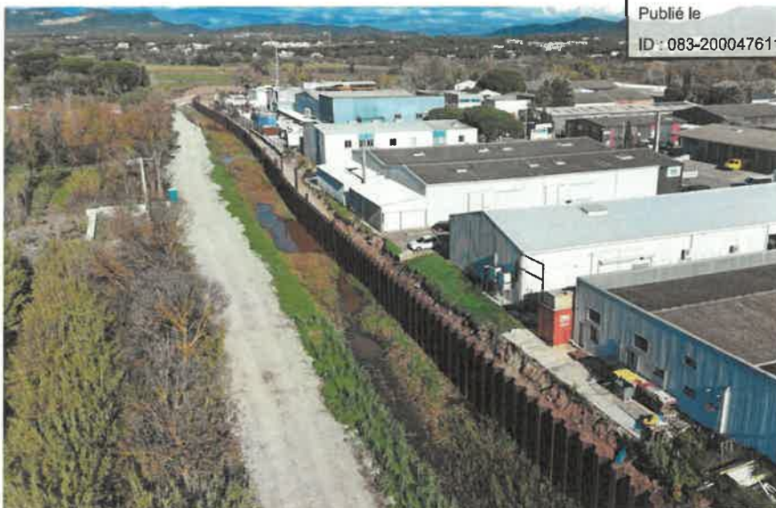
Digue ouest en rideau de palplanches
