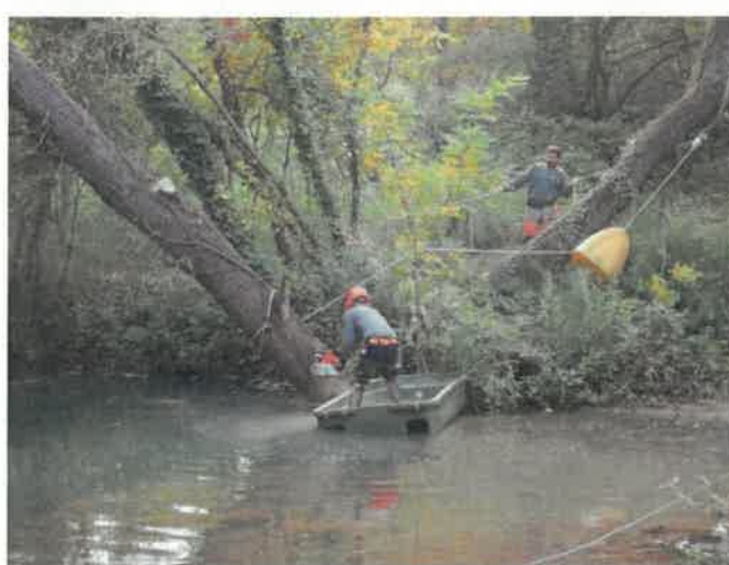
Débroussaillage de cannier le long du vallon des Prouits à la Motte et coupe d'un peuplier encroûé en travers du lit de la Bresque à Sillans-la-Cascade
