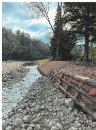
Génie Végétal à la suite du retrait de maçonneries.
