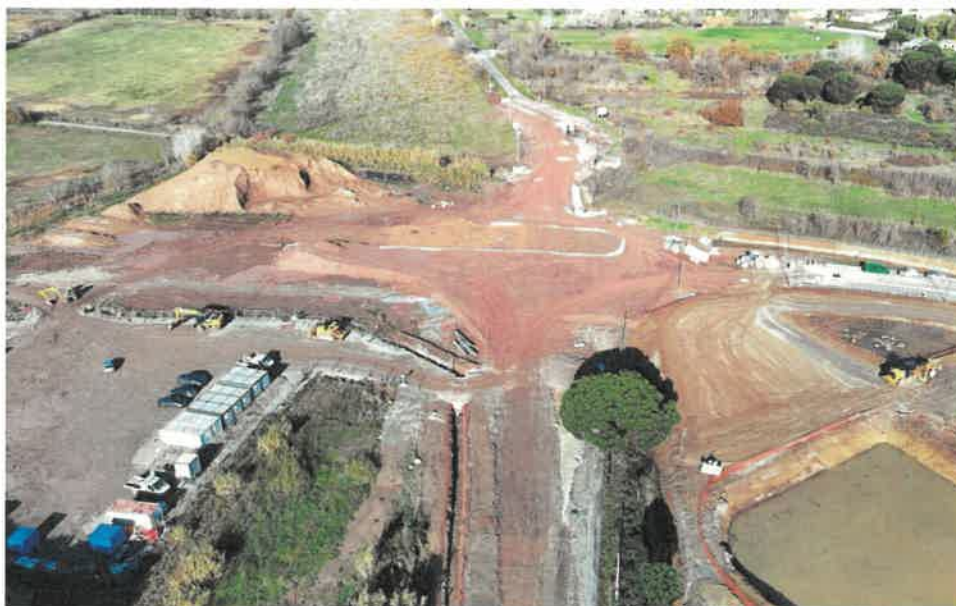
Création du giratoire à l'extrémité Est de la digue nord – Rue de la Vernède (livraison prévue début mars 2026).
