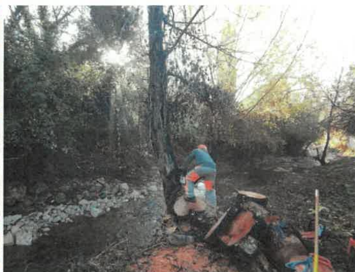
Réouverture de la section d'écoulement de la Nartuby à Montferrat et abattage arbre mort sur pied
