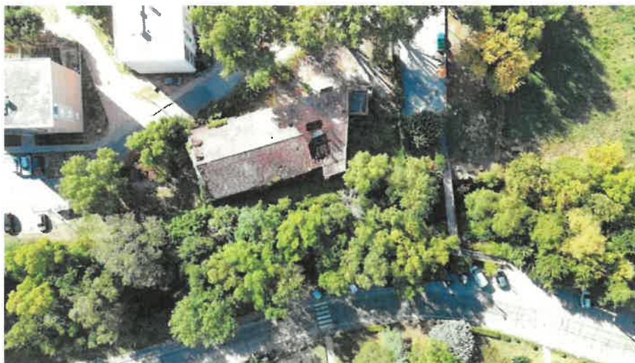
Vue aérienne de l'ancienne caserne (bâti communal) à démolir
