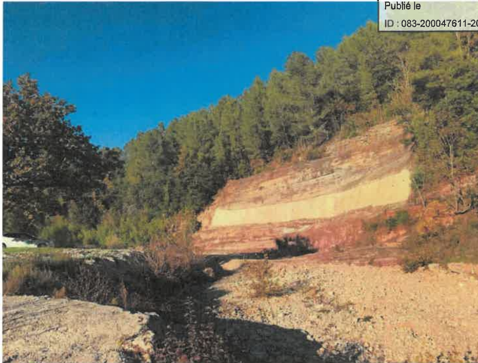
Photo de la mise en sécurité de la falaise (béton projeté et filet de protection)
