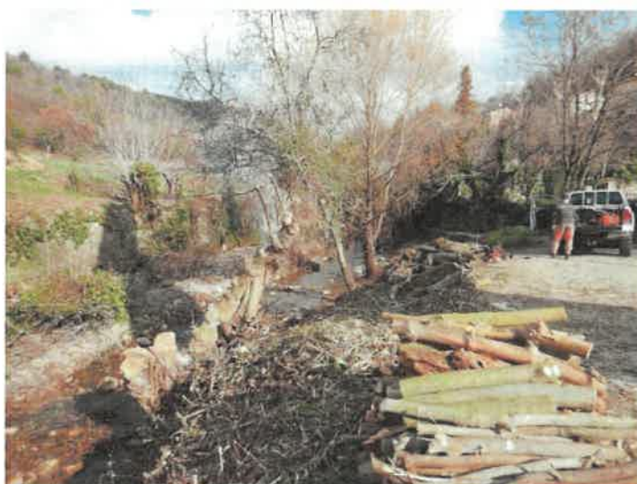
Réouverture de la section d'écoulement de la Nartuby à Montferrat et abattage arbre mort sur pied
