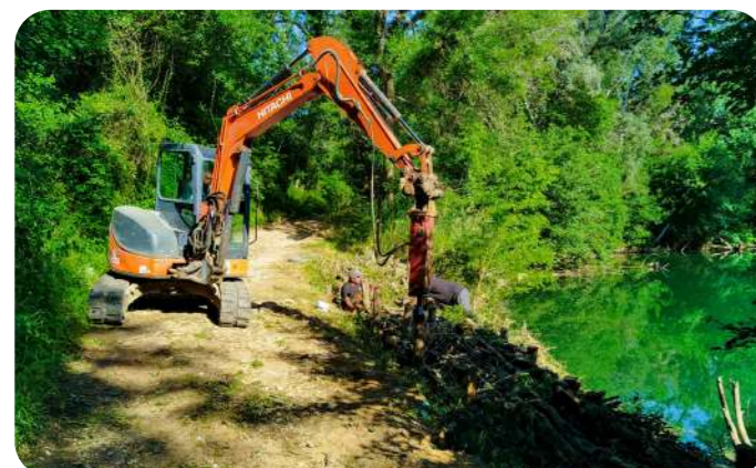
Réalisation d'un peigne sur l'Argens médian (Le Thoronnet)
