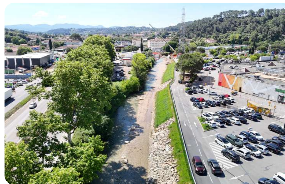
Élargissement et restauration des berges de la Nartuby au droit de la zone commerciale de Carrefour - marché M3 (entreprises FOREZIENNE-EGC-IDVERDE)
