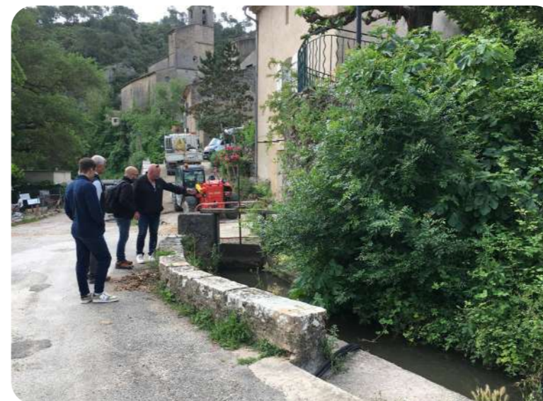
Visite de la prise d'eau des ferrages en présence du gestionnaire
