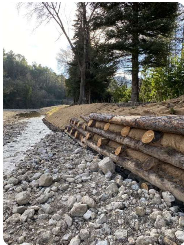
Génie végétal par caissons végétalisés, fascines et plantations en haut de berge
