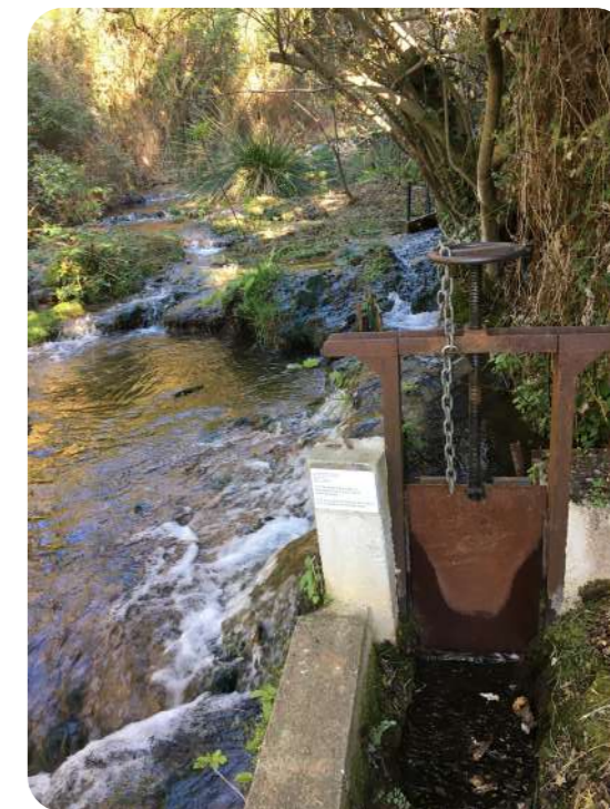
Martelière au niveau de la prise du canal de Saint Barthélémy
