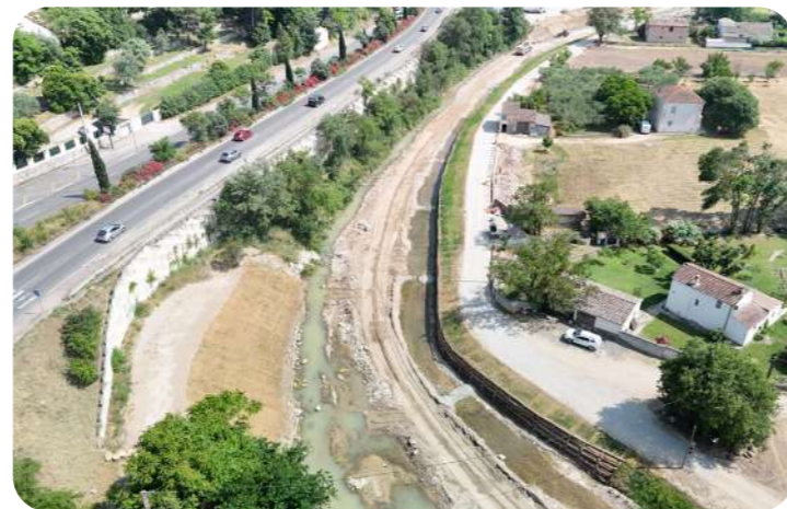
Élargissement et restauration des berges en technique végétale (caissons végétalisés) - marché M3 (entreprise Forézienne et ID Verde)
