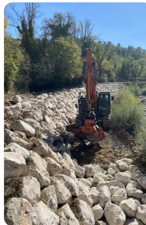
Enrochement libre de protection de la RD955 en cours de réalisation
