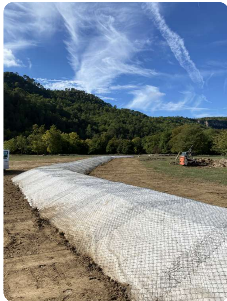
Merlon de protection rapproché en cours de réalisation
