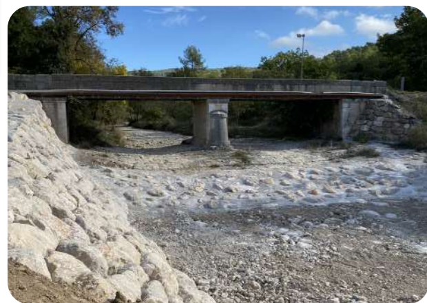
Confortement du radier du pont de la RD51
