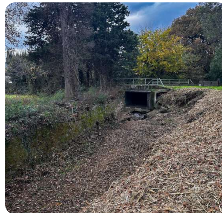
Réouverture du lit de la Vernède de Roquebrune
