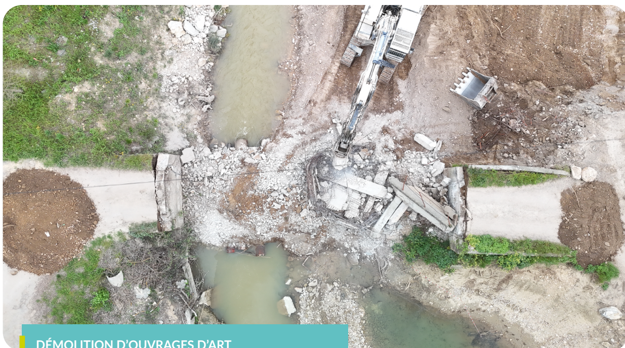
DÉMOLITION D'OUVRAGES D'ART LE PONT DES INCAPIS AVAL
