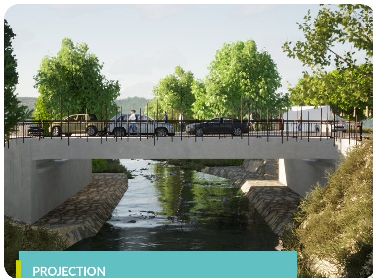
OUVRAGE ADAPTÉ AU NOUVEAU GABARIT DE LA NARTUBY
