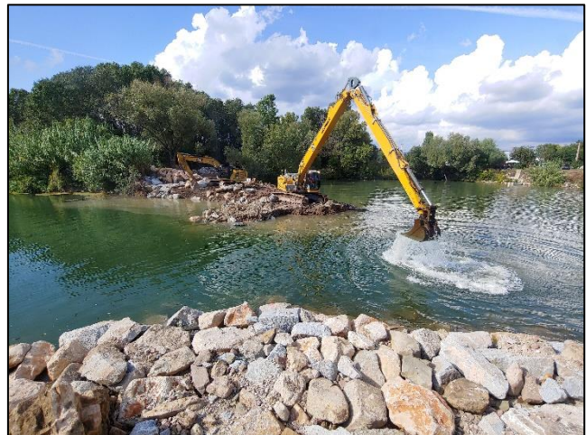
Photo 18 : Travaux sous maîtrise d'ouvrage SMA sur le seuil du Moulin des Iscles à Roquebrune/Argens
