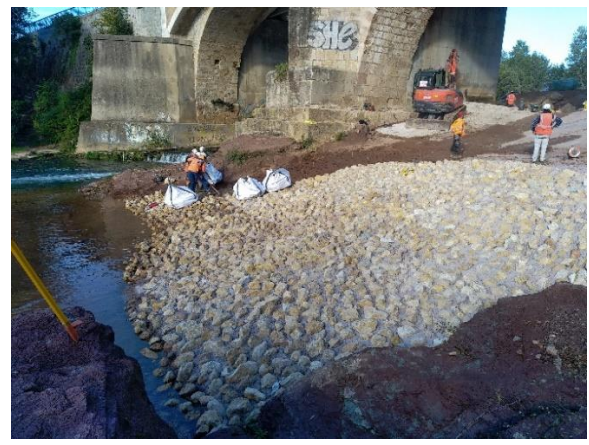
Photo 17 : Travaux d'amélioration de la libre circulation piscicole au Pont d'Argens en 2022
